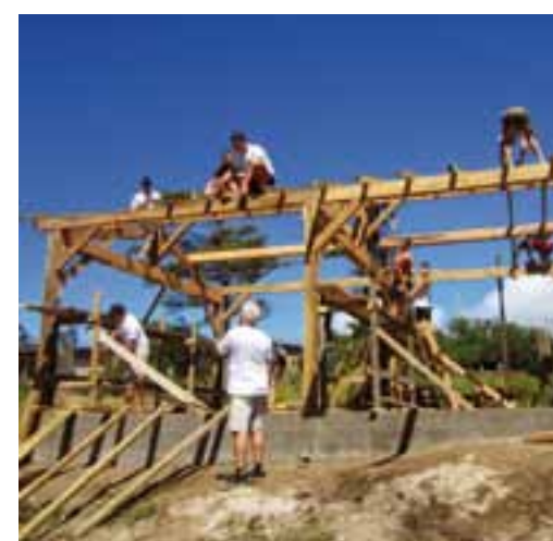
→ Les jeunes se prennent en charge et guident leurs aînés dans la réalisation du chantier en vrais patrons !
