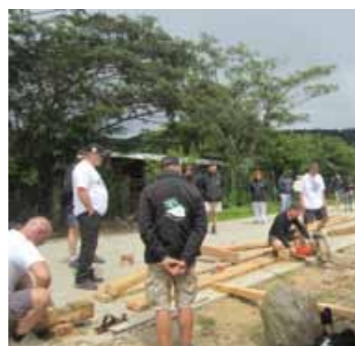
→ Sur le chantier, il faut préparer les bois, les transporter.
